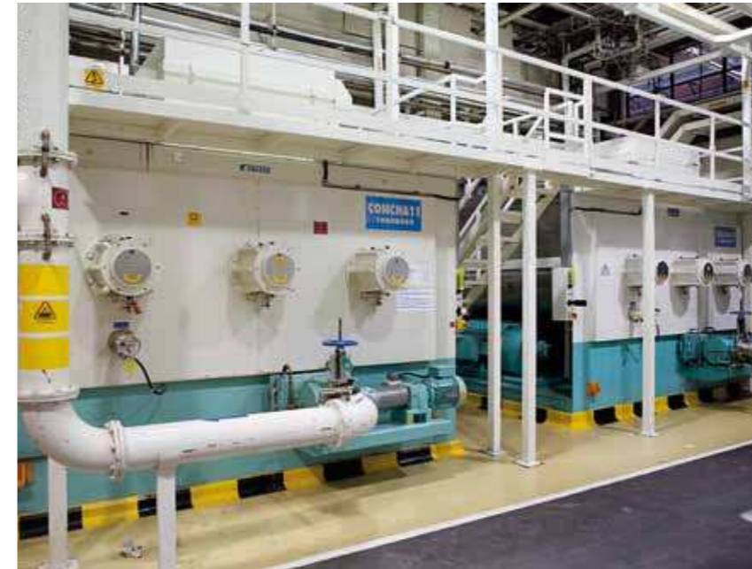
The shell – washing system, the Compañía Nacional de Chocolates Plant; Rionegro, Colombia.
