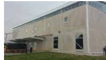
Centro de Distribución -CEDI- en la planta del Negocio Pastas, en Mosquera, Cundinamarca.
