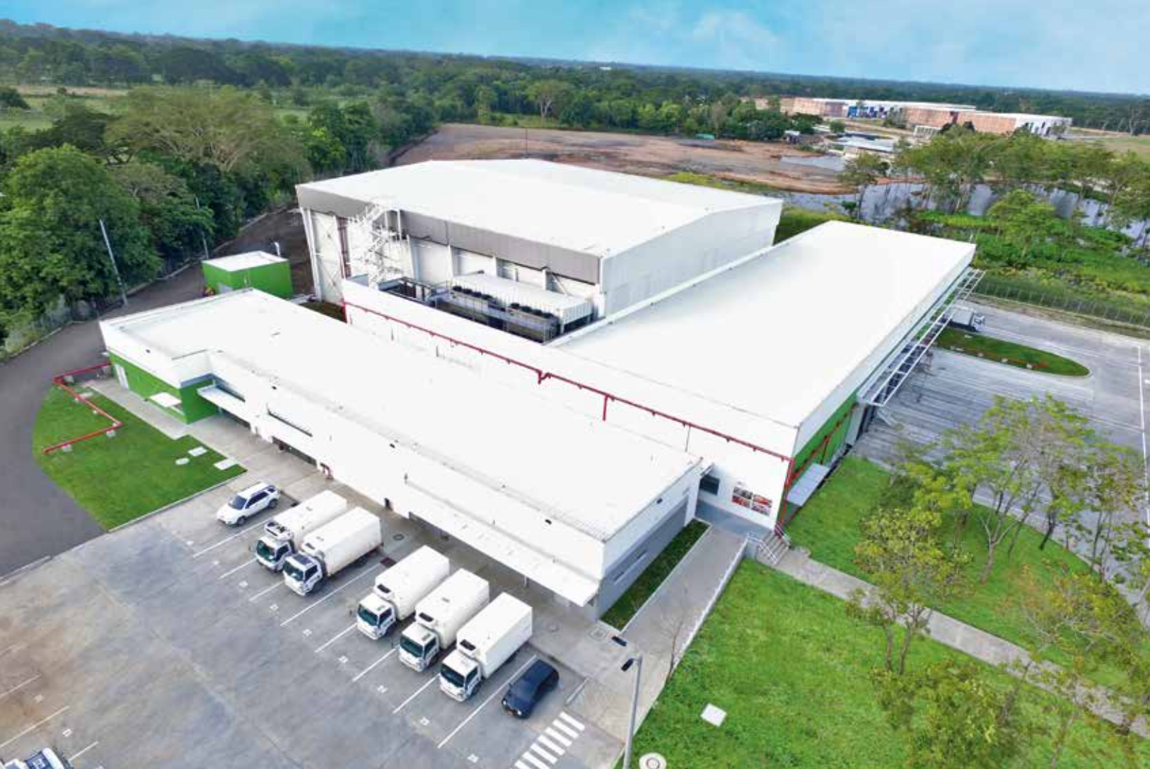
Centro de distribución del Negocio Cárnicos en Montería, Colombia.
