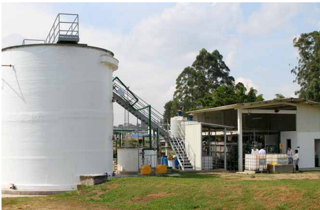
Planta de tratamiento de aguas residuales, Compañía Nacional de Chocolates Rionegro.
