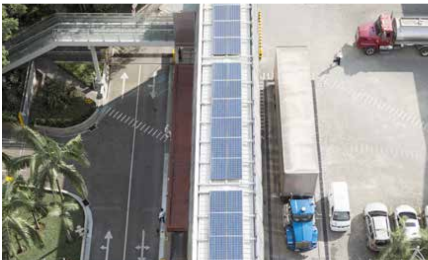
Paneles solares fotovoltaicos, Colcafé Medellín.
