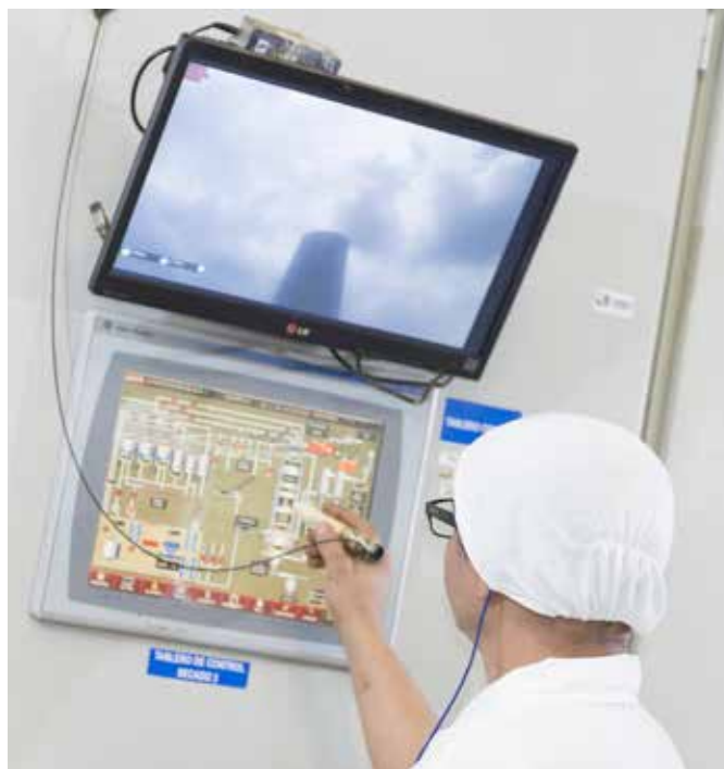
Sistema de control de emisiones en proceso de café soluble, Colcafé Medellín.
