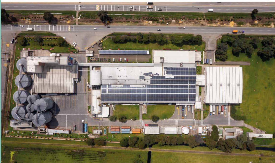
Paneles solares, planta Negocio Pastas, Mosquera, Colombia.
